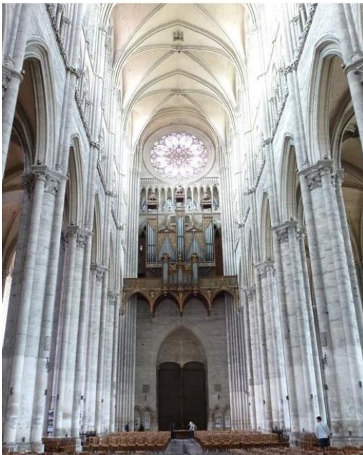
5-Orgue de tribune ; les travaux de maçonnerie concernent toute la travée de l'orgue, jusqu'à la voûte (Cliché DRAC)
