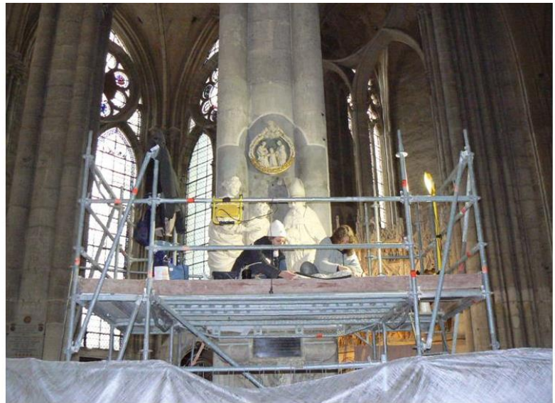
8-Monument de Claude Pierre, en cours de travaux par les restauratrices d'Arthéma. (cliché DRAC).
