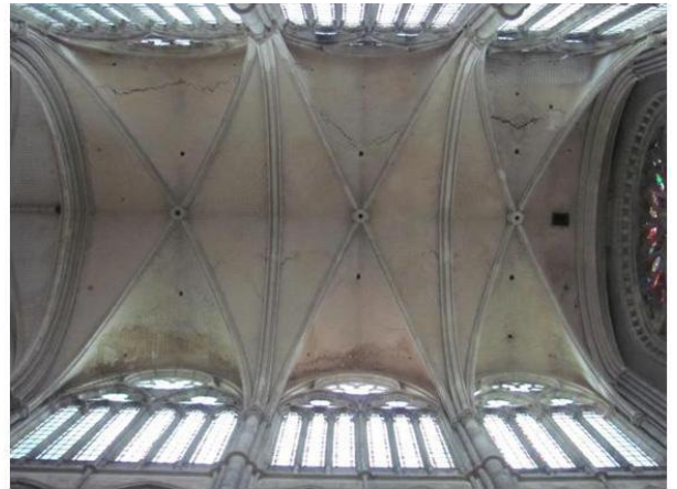
2-Bras sud du transept, voûtes, vue avant la pose du filet (cliché DRAC)
