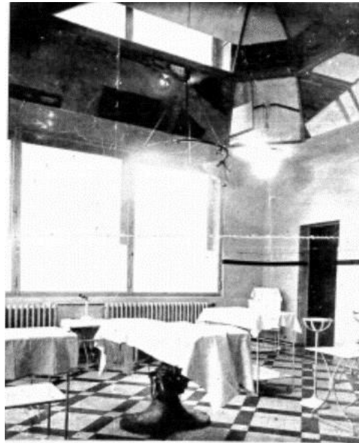
Fig.5 Salle du bloc opératoire de l'Hôpital Saint Michel conçue par V. Pauchet
