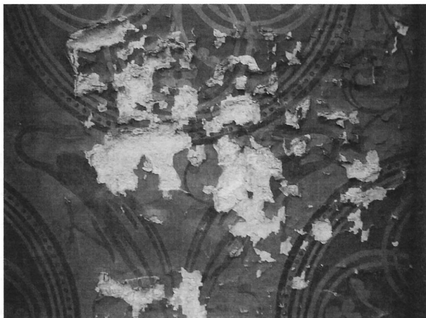
Chapelle de la Vierge, éclatement de la couche picturale, mars 2009, (ph. C. Durox)
