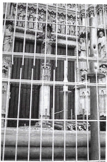
Le portail de la Vierge dorée en chantier
